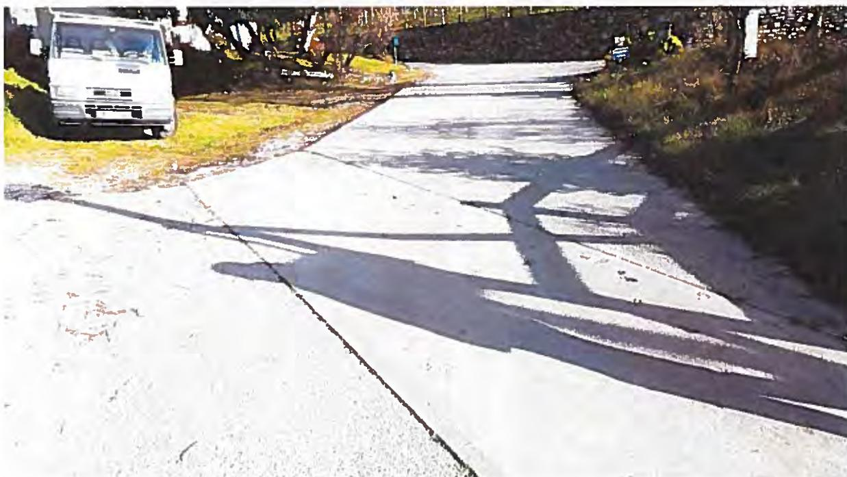
*Figura 5.20 – Guado del torrente Raboso attraverso la viabilità esistente*
