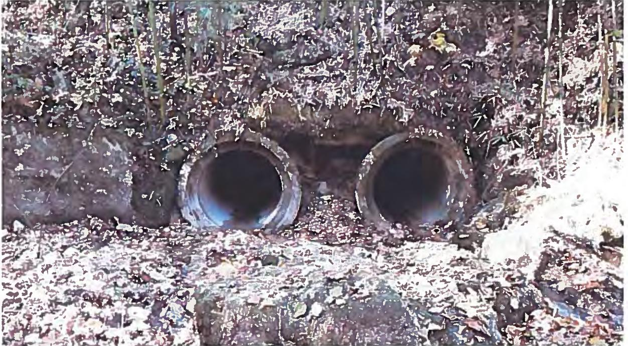
*Figura 5.44 – Condotte di attraversamento all'imbocco*
