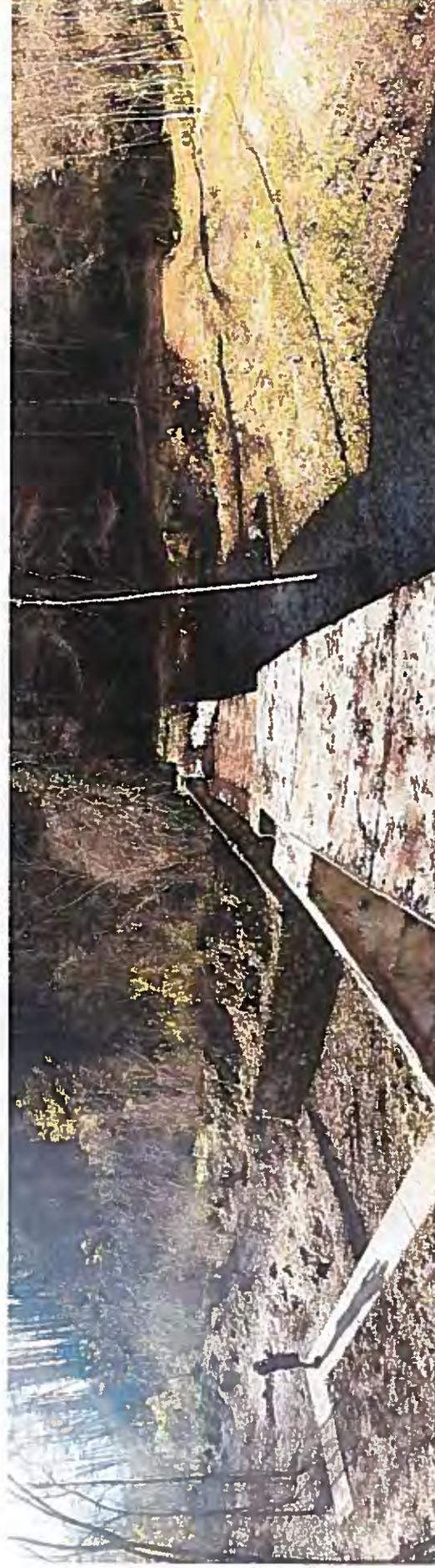
*Figura 5.18 – Briglia sul torrente Raboso a monte della frazione Guietta – Borgo Val – gaveta e vasca di accumulo del materiale solido*
