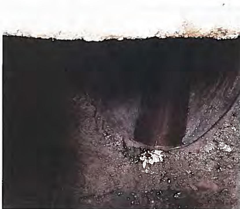
*Figura 5.48 – Condotta ovoidale a monte dell'immissione nel tratto tombinato della Val dei Carop*
