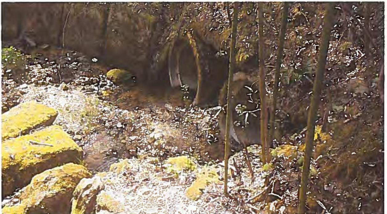
*Figura 5.45 – Condotte di attraversamento all'imbocco*
