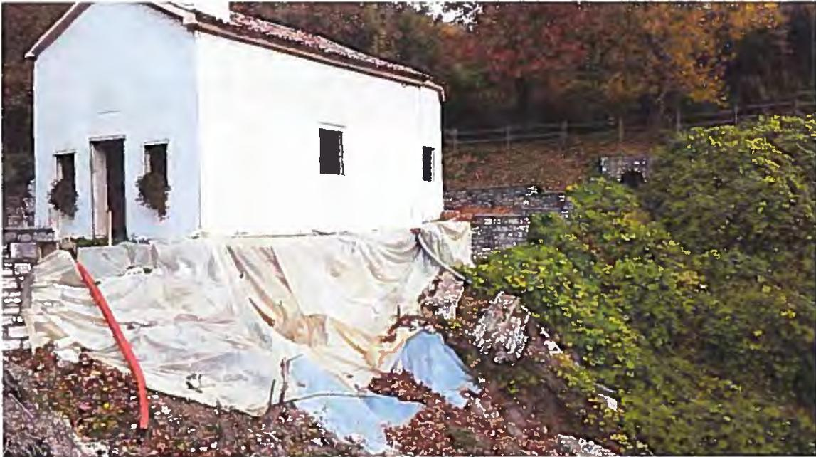
*Figura 5.7 – Erosione a valle della chiesetta di San Vito*
