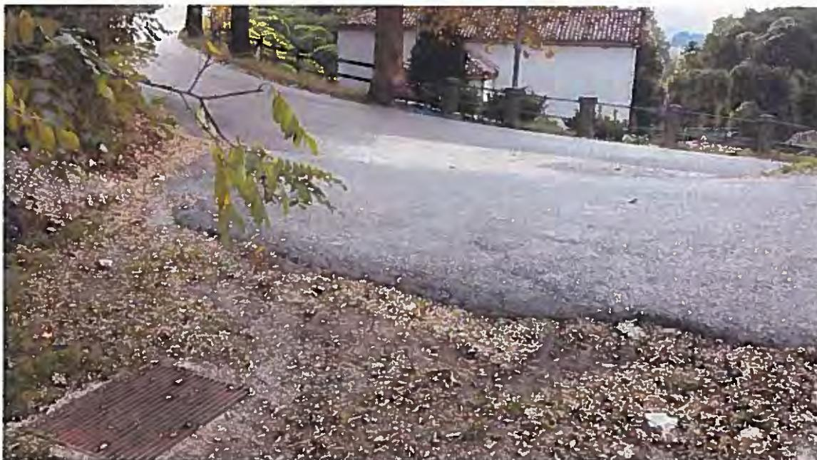
*Figura 5.2 – Captazione acque provenienti da monte tramite tombino a raso*
