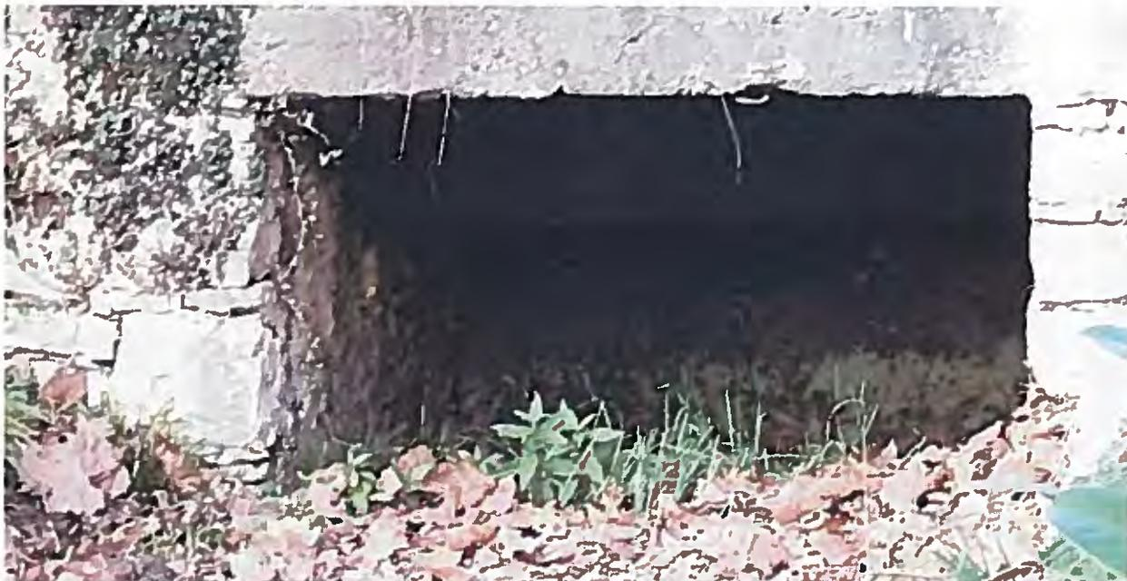
Figura 3.2 – Sezione di sbocco parzialmente ostruita
