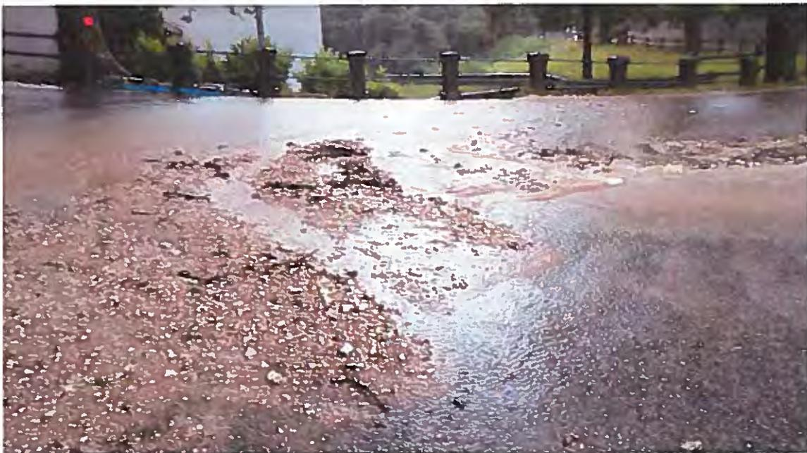
*Figura 5.5 – Evento di pioggia di Giugno 2016, le acque scorrono in strada e il tombino di presa è interamente interrato – da segnalazione dei cittadini Giugno 2016*
