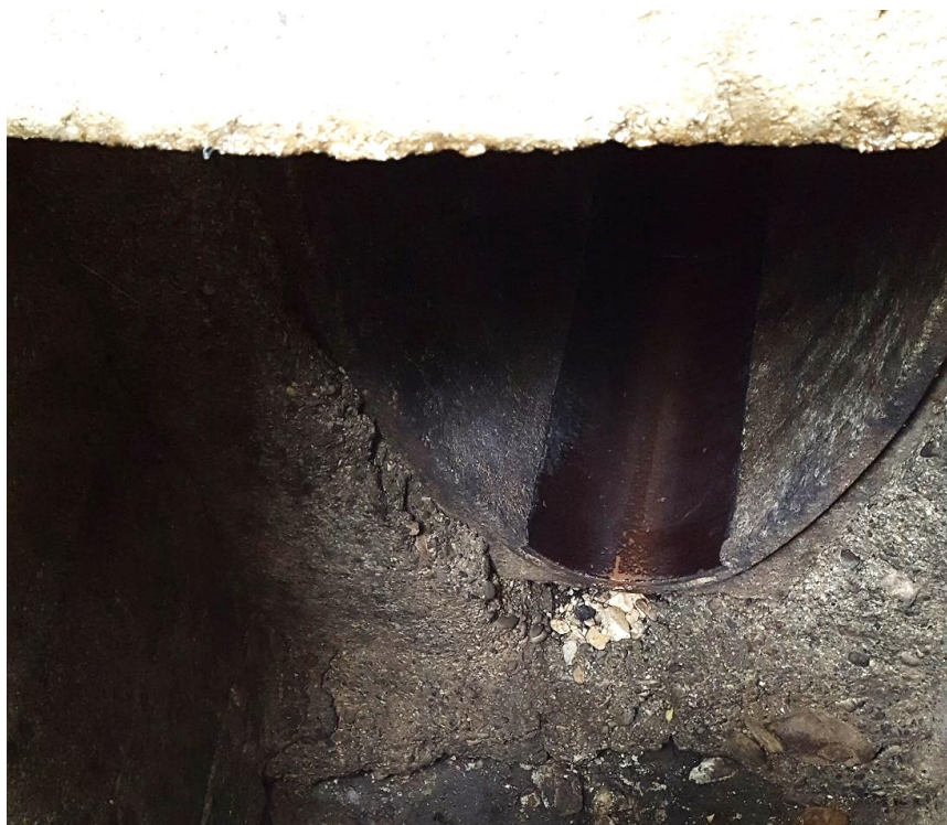
Figura 5.32 – Condotta ovoidale a monte dell'immissione nel tratto tombinato della Val dei Carop
