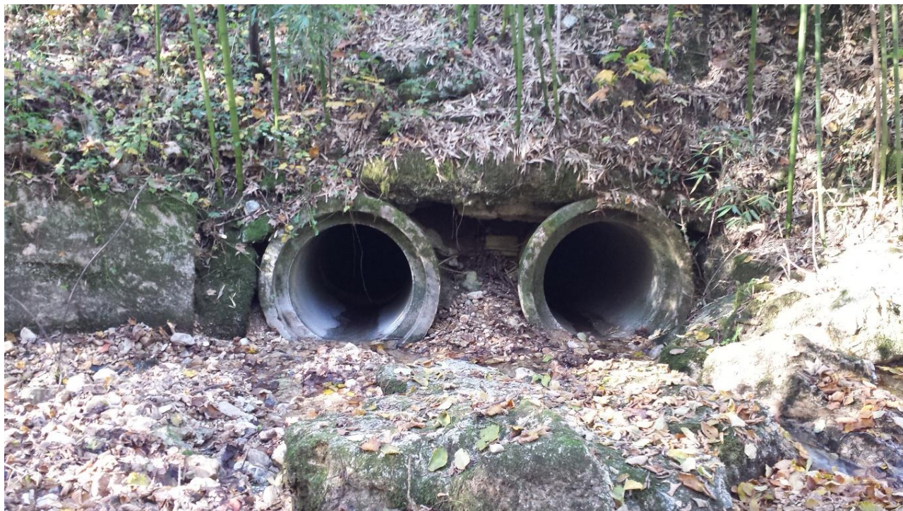
Figura 5.28 – Condotte di attraversamento all'imbocco
