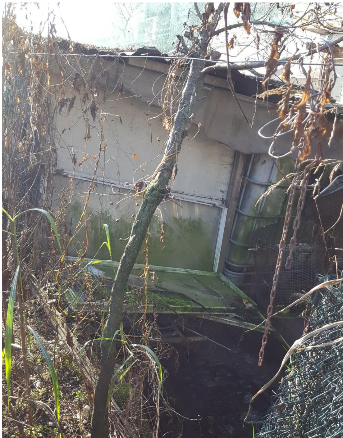
Figura 5.37 – Edificio abusivo in alveo
