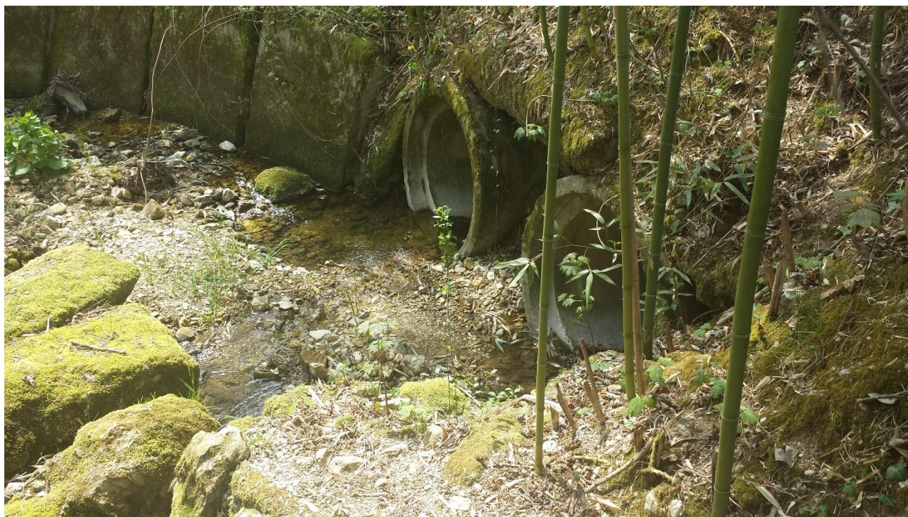
Figura 5.29 – Condotte di attraversamento all'imbocco
