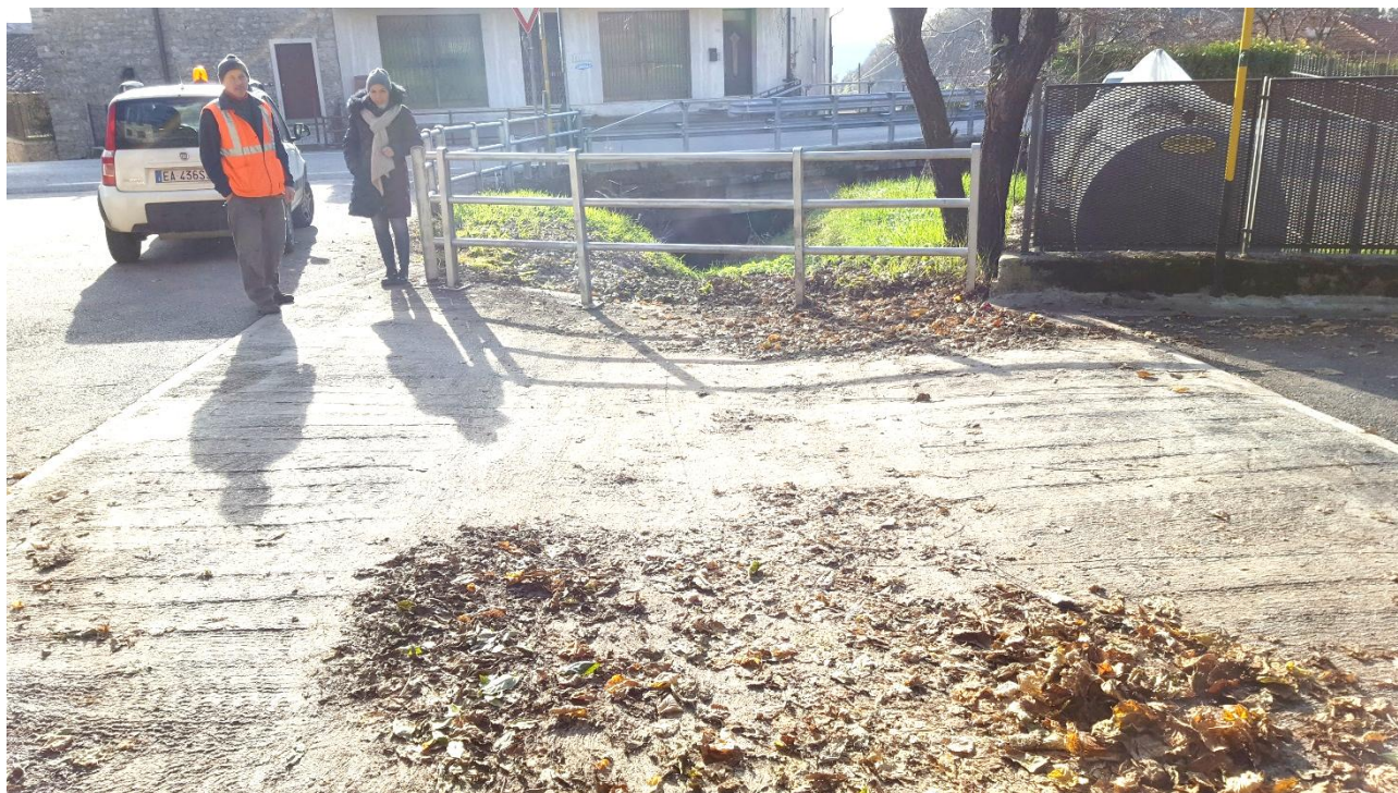
Figura 5.6 – Guado del torrente Raboso a monte dell'attraversamento sulla SP 36
