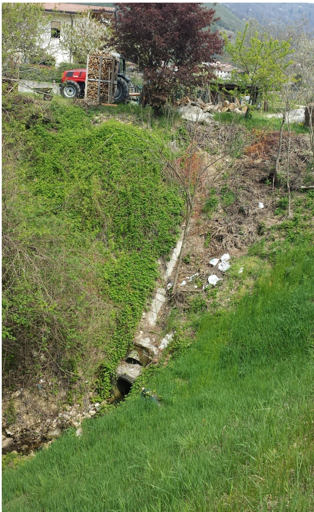
Figura 5.30 – Condotte di attraversamento allo sbocco
