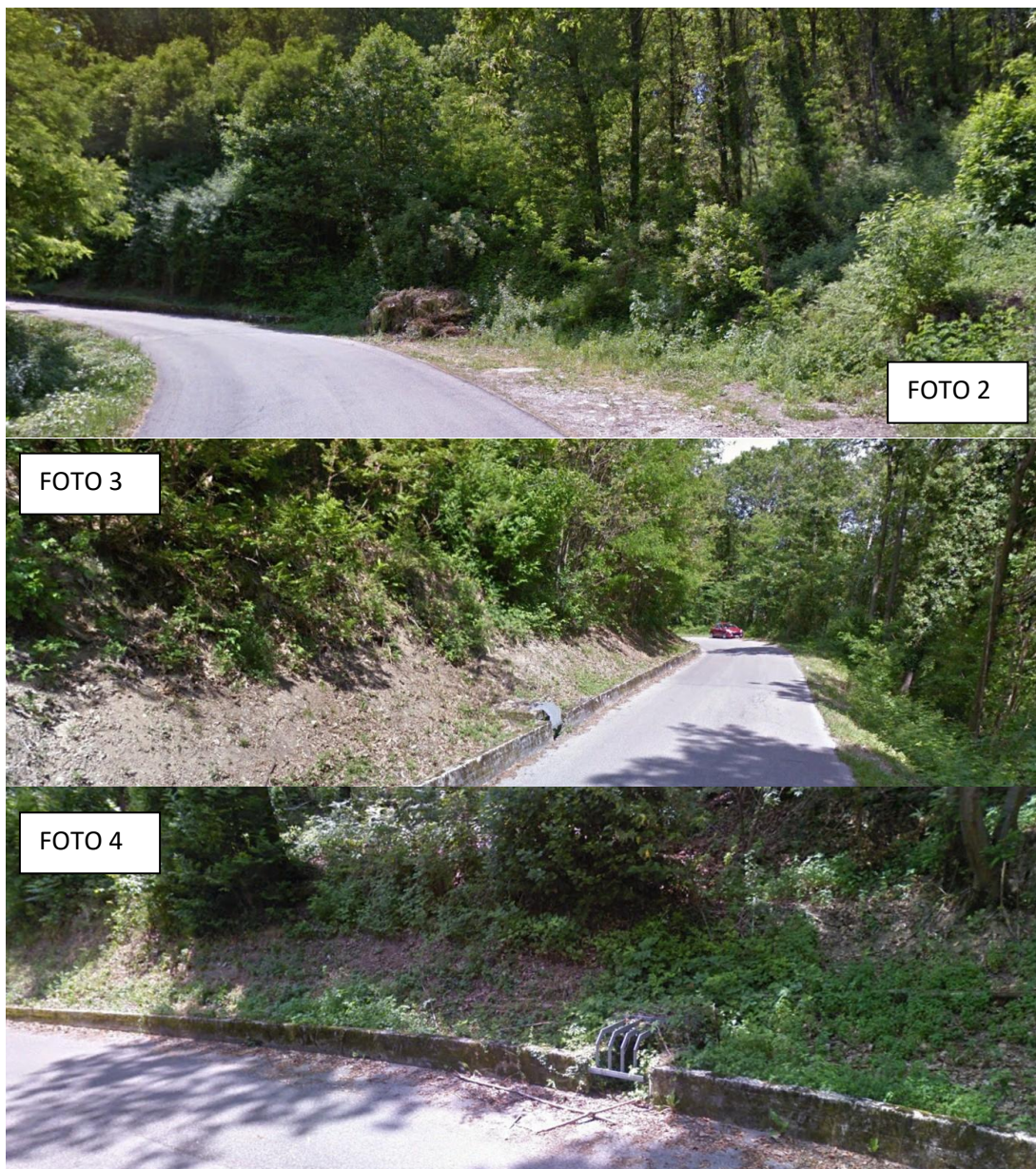
Figura 5.43 – Foto 1-4 Il tratto della Strada di Madean mostra scarpate a monte con vegetazione densa e segni di erosione dovuti al ruscellamento, con acqua che scorre sulla sede stradale verso valle.
