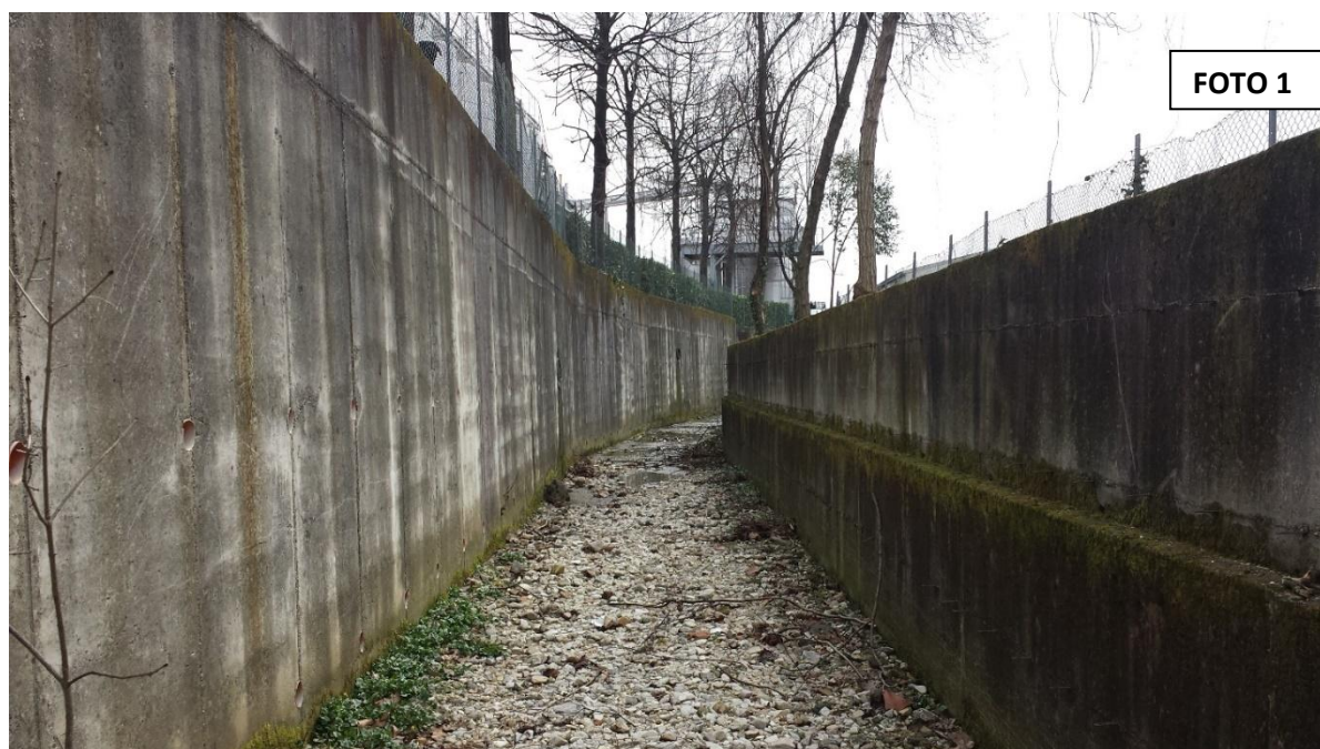
Figura 5.20 – Tratto sistemato a cunettone
