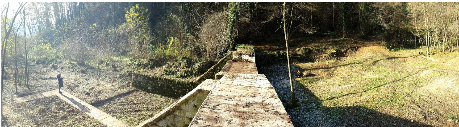
Figura 5.3 – Briglia sul torrente Raboso a monte della frazione Guietta – Borgo Val – gaveta e vasca di accumulo del materiale solido
