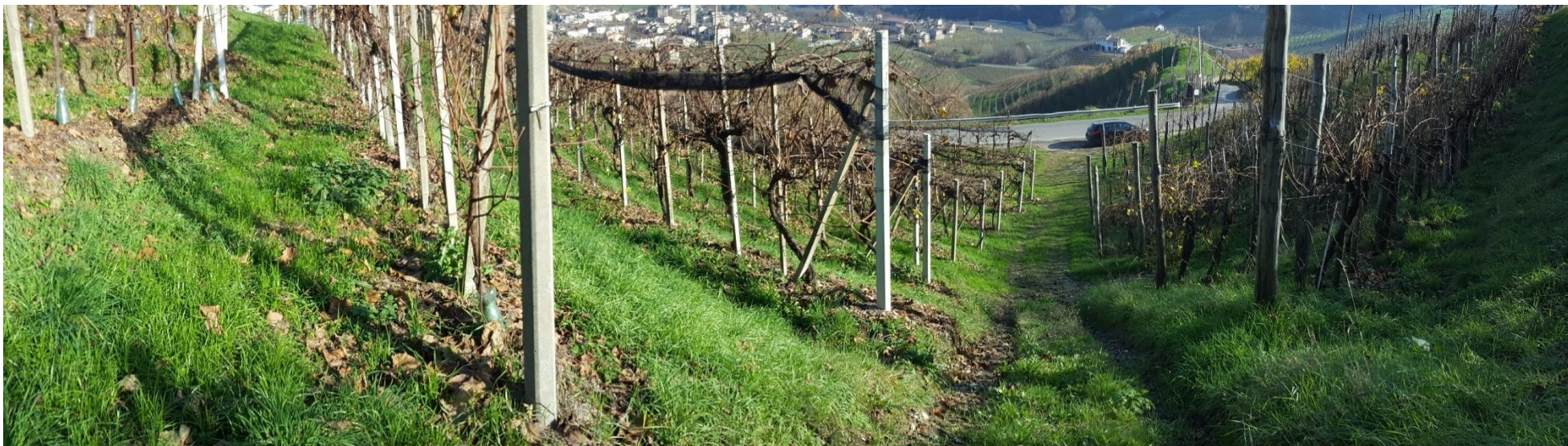
Figura 5.13 – Avvallamento a monte della SP36
