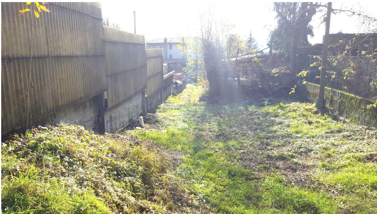
Figura 5.4 – Alveo del torrente Raboso interferente con la viabilità interpoderale
