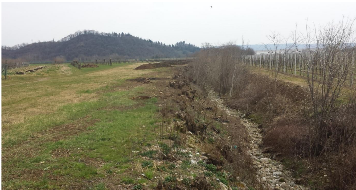
Figura 5.25 – Tratto di alveo a valle dell'attraversamento di via San Giovanni
