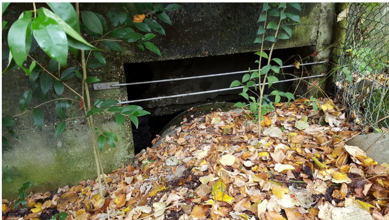
Figura 3.12 – imbocco nella condotta di tracciato ignoto
