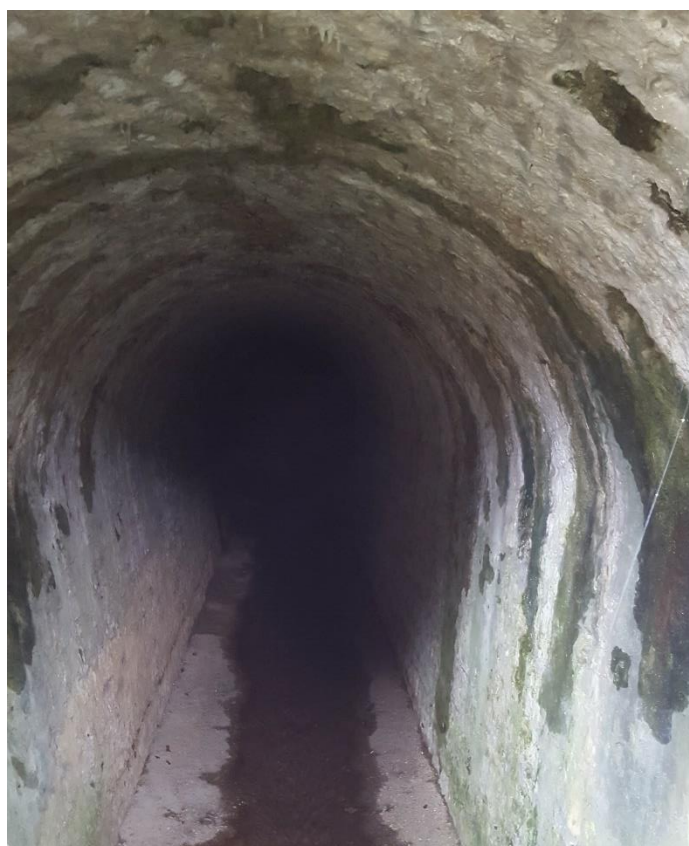
Figura 3.13 – Attraversamento della SP9 tramite un cunicolo carrabile
