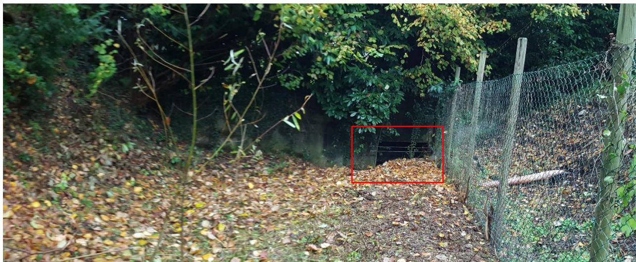
Figura 3.11 – imbocco nella condotta di tracciato ignoto
